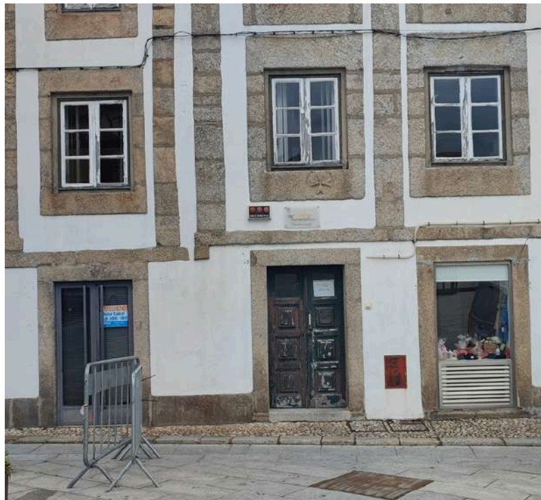
Instalações do CRI Guarda
